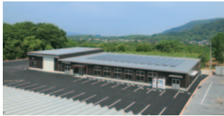
敷地1000坪、建物面積300坪、 屋根には太陽光発電を設置した新社屋
